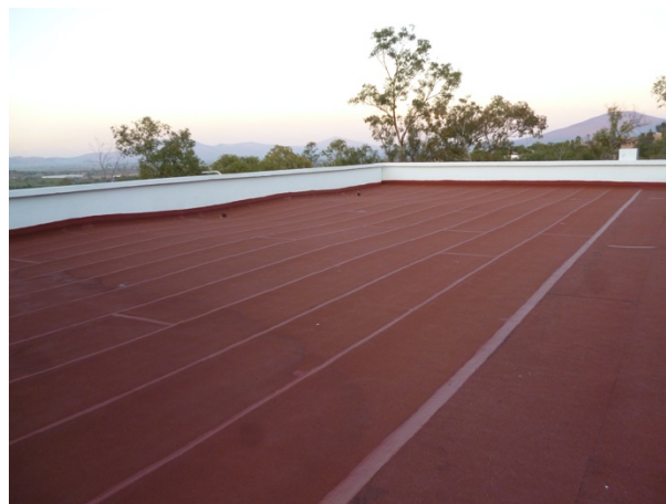
Ilustración 20 Impermeabilización del Edificio Y
